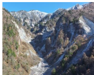
白谷砂防堰堤群
