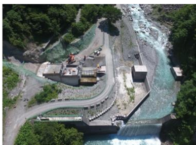
黒薙川第2号下流砂防堰堤
