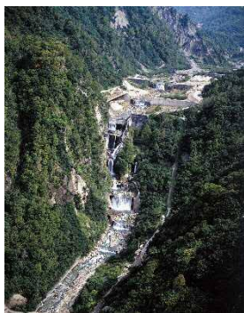
重要文化財「白岩砂防堰堤
