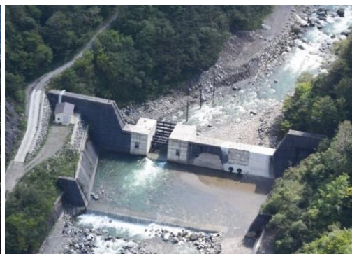
妙寿砂防堰堤（シャッター付砂防堰堤）
