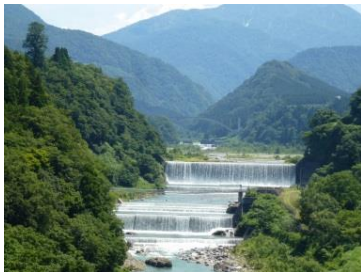
本宮砂防堰堤
